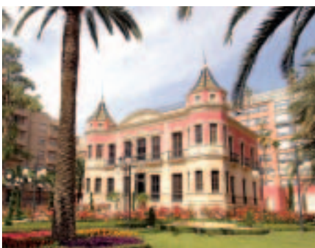
Edificio que alberga la sede del del Instituto Universitario de Estudios Fiscales y Financieros de la Universidad de Murcia.
