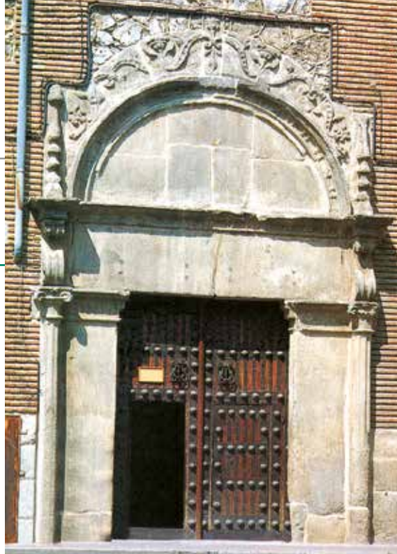
Fachada del Convento de las Descalzas Reales, ocupaba la antigua manzana 394.
